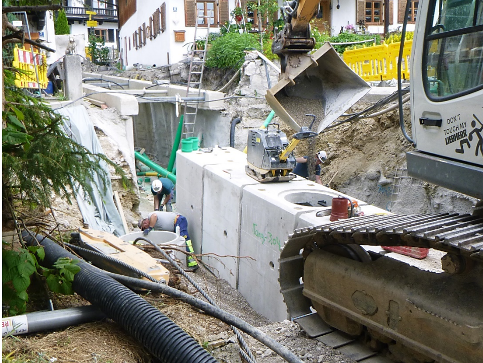
Bauabschnitt Hausbergstraße: Verlegung des neuen, wesentlich leistungsstärkeren Hochwasserkanals in der Hausbergstraße
