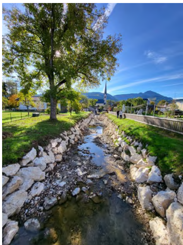
Abbildung1: Nahe der Kirche in Bergen läuft derzeit der erste, etwa 100 Meter lange Bauabschnitt zur Sanierung des Bergener Bachs. Für seinen Unterhalt ist das Wasserwirtschaftsamt Traunstein mit seiner Fluss- meisterstelle Traunstein zu- ständig. Foto: Wasserwirtschaftsamt Traunstein
