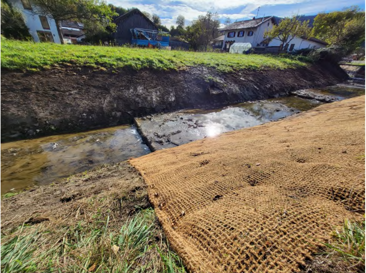
Abbildung 2: Flussabwärts, Richtung Brücke an der Campingstraße, schützen großzügig ausgelegte Kokosmatten eine Uferseite vor Erosion. Sie sind mit Holznägeln befestigt und werden nach und nach wieder von Gras bewachsen. Die kleinen Abstürze im Bachbett werden noch durchgängig gestaltet, damit Fische sie überwinden können. Foto: Wasserwirtschaftsamt Traunstein
