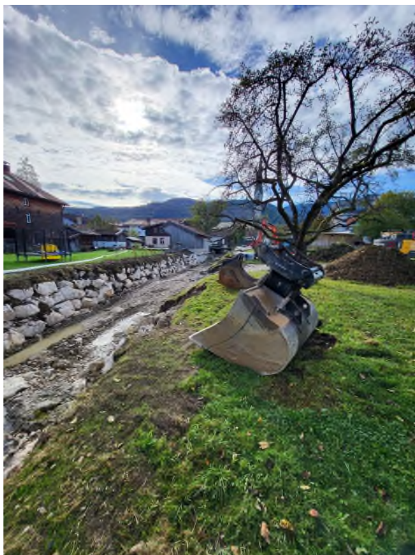
Abbildung 3: Der Obstanger in Bergen dient derzeit als Zufahrt zur Baustelle und als Lagerfläche. Besonderes Augenmerk wird auf den Schutz der alten Obstbäume gelegt. Nach Abschluss der Arbeiten wird das Areal renaturiert. Foto: Wasserwirtschaftsamt Traunstein
