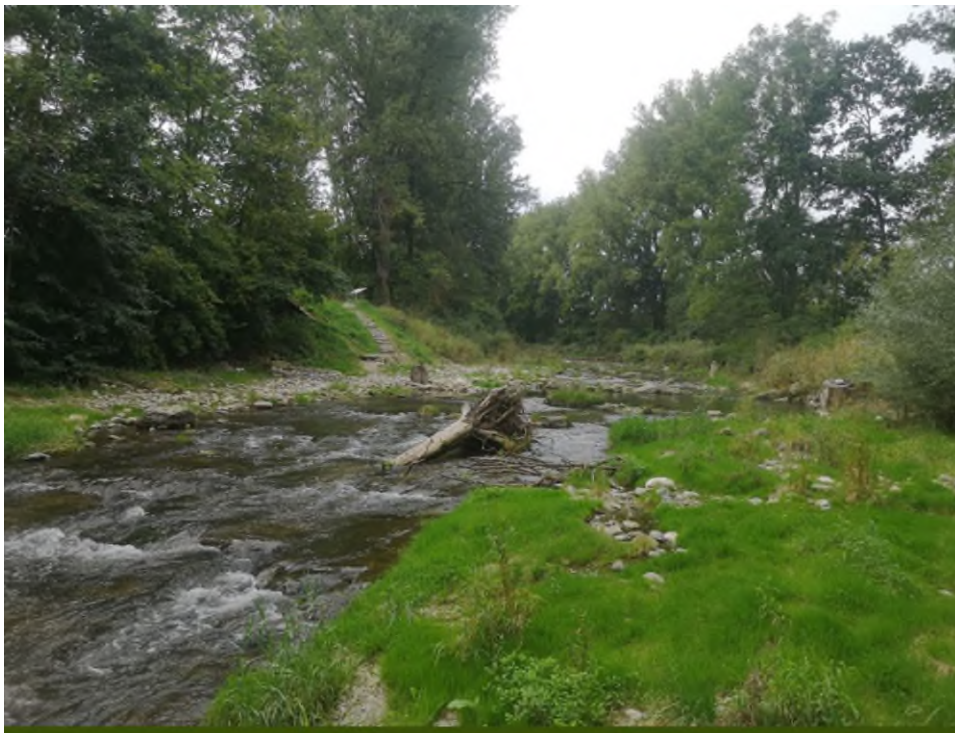
Abb. 2: Neue Strukturen und eine Fischaufstiegshilfe im Wasser schaffen neuen Lebensraum für Fische, die vom Inn in die Isen schwimmen. Nase, Barbe und Äsche können jetzt flussaufwärts neue Laichplätze sowie Plätze zur Nahrungsaufnahme finden.
