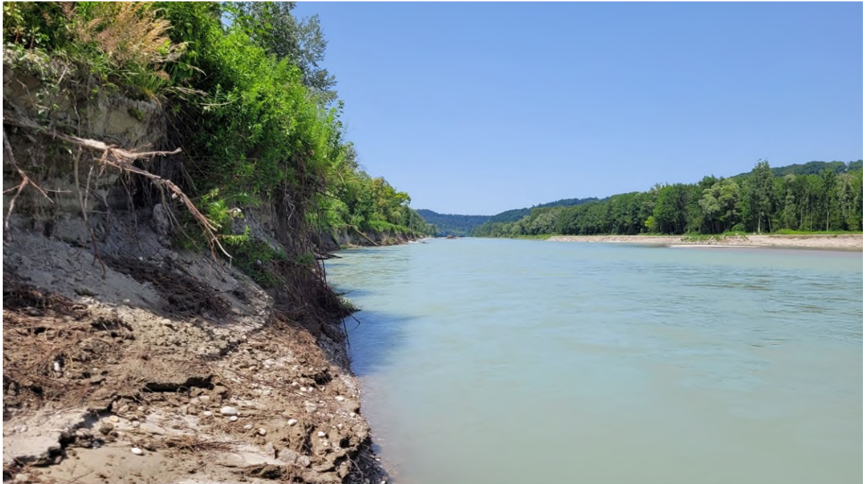
Abb. 3: Die Uferaufweitung der Salzach bei Tittmoning ist abgeschlossen. Mit dem Ausbau der Uferbefestigung hat der Fluss mehr Platz bekommen. Neue Lebensräume sind sowohl im Wasser als auch an Land entstanden. Auch das Ziel, die Sohle des Flusses zu stabilisieren, ist erreicht.
