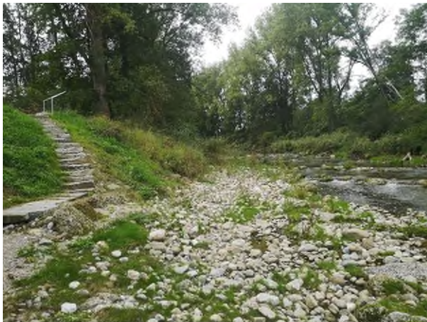
Abb. 1: Mit dem Umbau des Absturzes in der Isen am Sportplatz in Winhöring ist auch ein Zugang zum Gewässer entstanden. Die Höhe des Absturzes wurde verringert, eine Sohleite ermöglicht Fischen, die Hürde zu überwinden.
