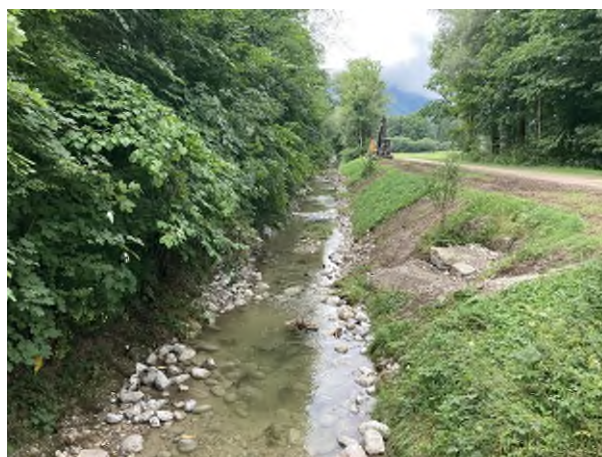
Abbildung 5: Der Wössener Bach ist aus seinem starren Korsett befreit. Das Ufer ist aufgelockert, die Holzbretter vom Grund des Baches sind verschwunden. Das Bachbett ist zu einer mäandrierenden Wasserrinne umgestaltet. Hier finden Fische nicht nur eine ausreichende Wassertiefe: Fischunterstände, aus Steinen gelegt, bieten ihnen ebenso Schutz wie Wurzelstöcke aus Totholz.
