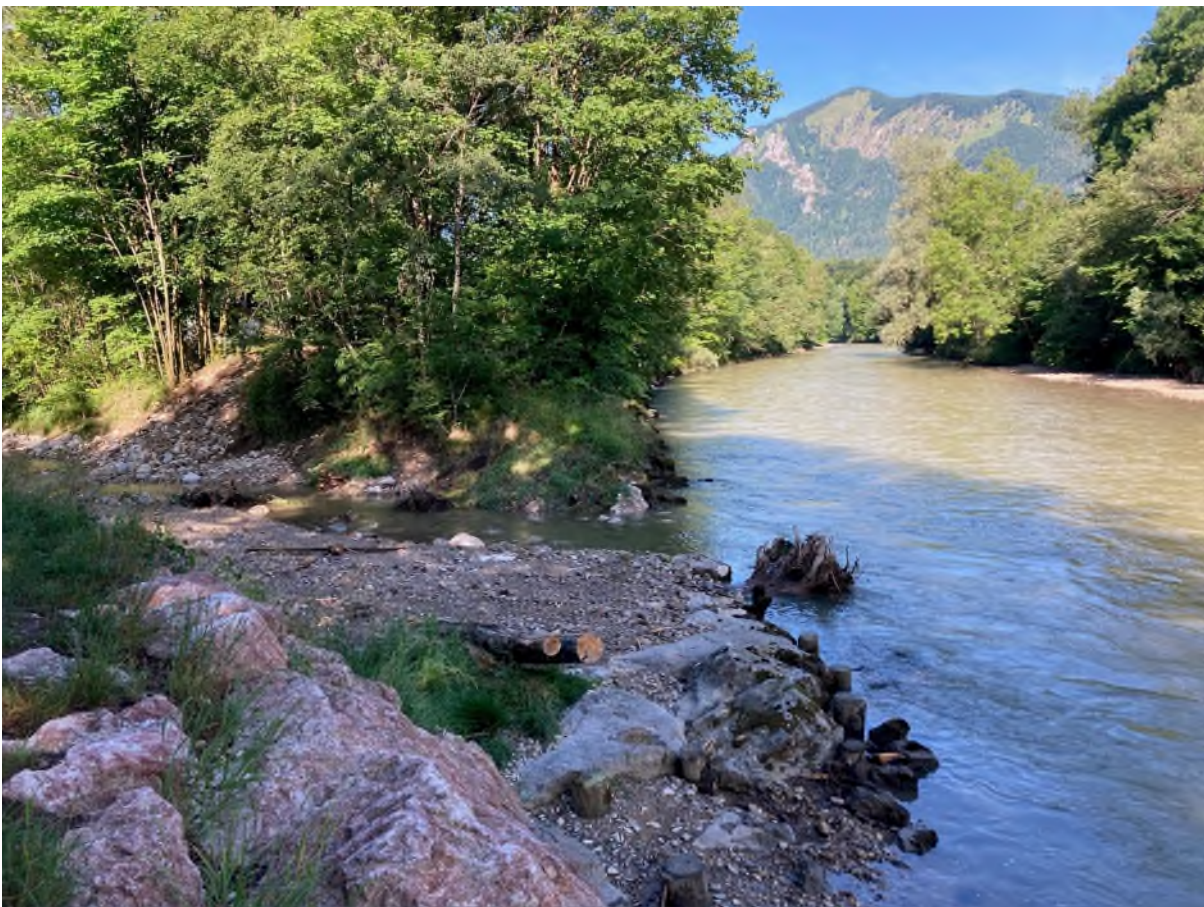
Abbildung 3: Der Weg von der Tiroler Achen in den Wössener Bach und umgekehrt ist frei. Fische können nun in den Bach schwimmen, wo sie ideale Lebens- und Laichbedingungen vorfinden. Foto: Wasserwirtschaftsamt Traunstein
