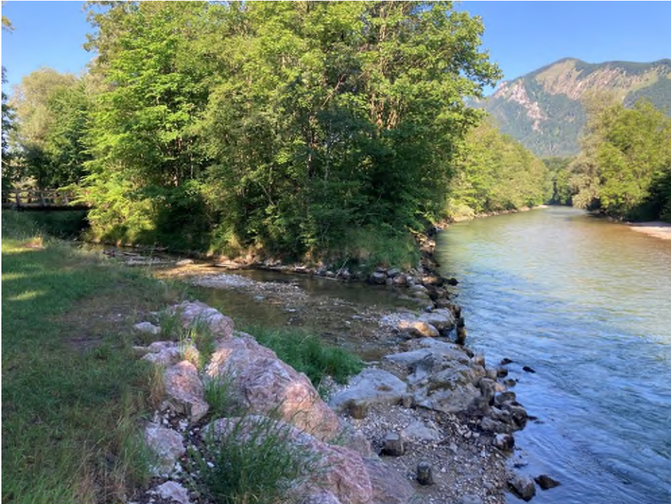
Abbildung 2: Wo der Wössener Bach in die Tiroler Achen mündet, haben bisher Steine die Durchgängig- keit versperrt. Für Fi- sche ein unüberwindba- res Hindernis. Foto: Wasserwirt- schaftsamt Traunstein
