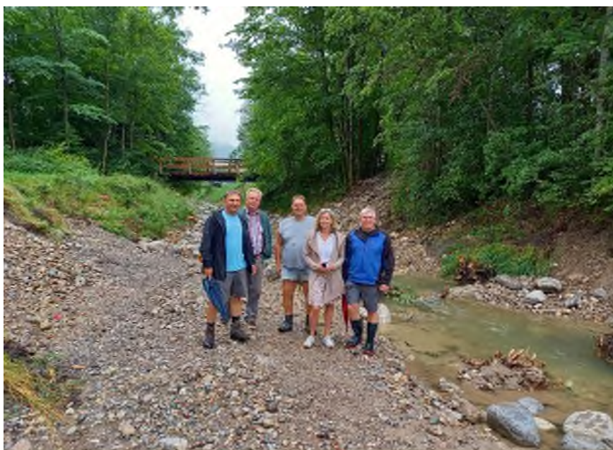
Abbildung 1: Der Unterwössener Bürgermeister Ludwig Entfellner (Zweiter v.l.) und die stellvertretende Bauamtsleiterin der Kommune, Jana Schmidt-Hindinger, besuchen die Baustelle am Wössener Bach in Unterwössen. Die beiden Mitarbeiter des Traunsteiner Wasserwirtschaftsamtes, Andreas Philipp (l.) und Stefan Hollrieder (r.) erläutern die ökologische Umgestaltung des Baches. Baggerfahrer Charly Moser sorgt dafür, dass rund 200 Tonnen Steine richtig angeordnet und verbaut werden. Foto: Wasserwirtschaftsamt Traunstein
