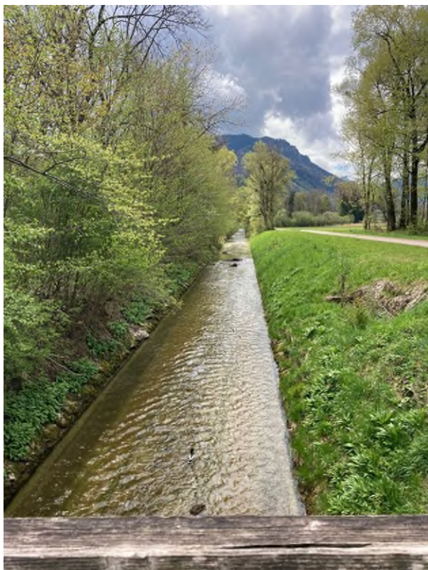
Abbildung 4: Wie in einem Kanal fließt das Wasser vor dem Umbau im Wössener Bach. Holzbretter am Grund des Baches sichern zwar die Gewässersohle, verhindern aber natürliche Strömungsverhältnisse. Ökologisch ist hier nicht viel los.
