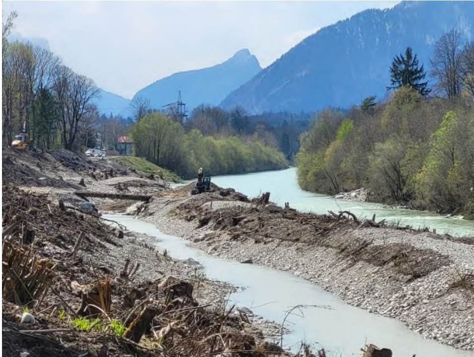
Abbildung 2: Die Arbeiten zur Aufweitung des Saalach-Ufers auf österreichischer Seite verlaufen planmäßig. Unzählige Tonnen an Erdreich, Stein und Kies werden bewegt, um dem Fluss mehr Raum zu geben. Das Flussbett verbreitert sich von 28 auf 60 Meter. Foto: Wasserwirtschaftsamt Traunstein
