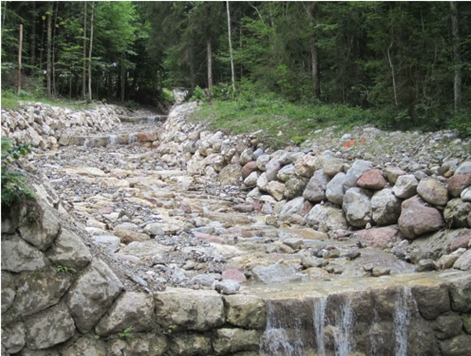
Abbildung 2: Mitarbeiter der Fluss- meisterstellen Piding und Traunstein haben den Klingerbach freige- räumt und die Ufersi- cherungen wiederherge- stellt. Nun fließt der Bach ruhig und sicher in seinem Bachbett. Foto: Wasserwirtschaftsamt Traunstein
