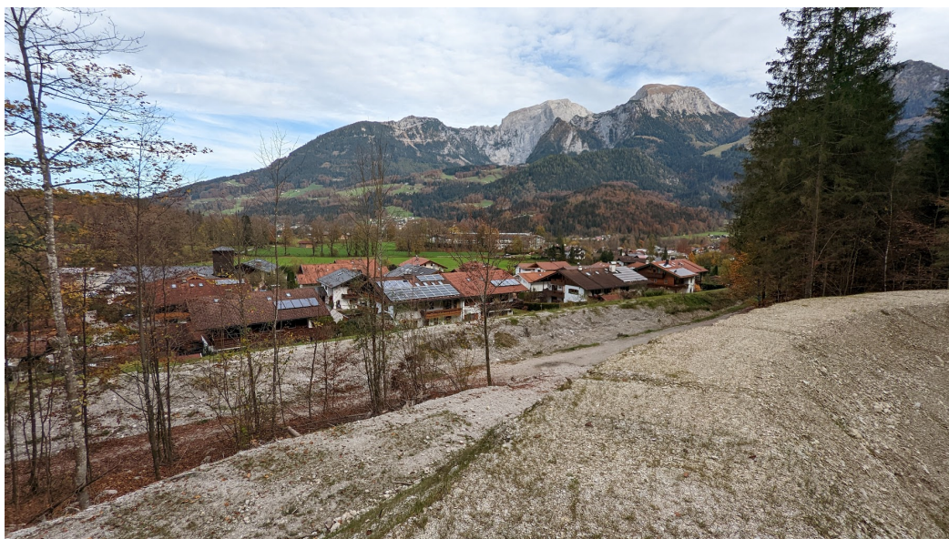
Abbildung 3: Am Fuße des Grünsteins, auf Höhe der Waldhausersiedlung, hat die Flussmeisterstelle Piding ein großes Auffangbecken errichtet und den Damm verstärkt. Foto: Wasserwirtschaftsamt Traunstein
