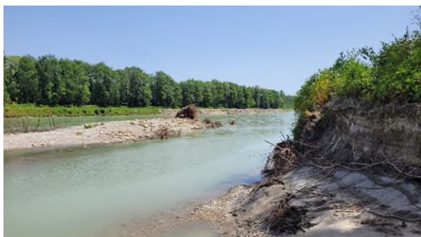
Abbildung 1: Die Arbeiten aus dem ersten Bauabschnitt bei Tittmoning zeigen bereits Erfolge: Die Untere Salzach hat weiche Ufer bekommen. Die aus Kies, alten Ufersteinen und Totholz angelegte Insel fügt sich ganz natürlich in die Umgebung. Foto: Wasserwirtschaftsamt Traunstein
