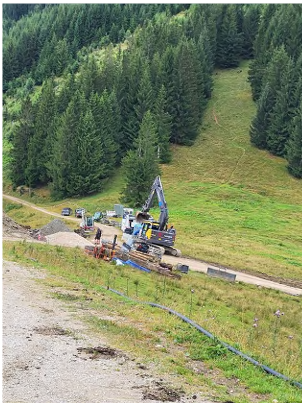
Abb. 1: Bis unterhalb der Bergwachthütte auf dem Unternberg bei Ruhpolding sind die Rohre bereits verlegt. Jetzt laufen die Vorbereitungsarbeiten für den nächsten Bauabschnitt. Er reicht von der Boider Alm bis zur Unternberg Alm beziehungsweise zur Sesselbahn-Bergstation. Foto: Wasserwirtschaftsamt Traunstein
