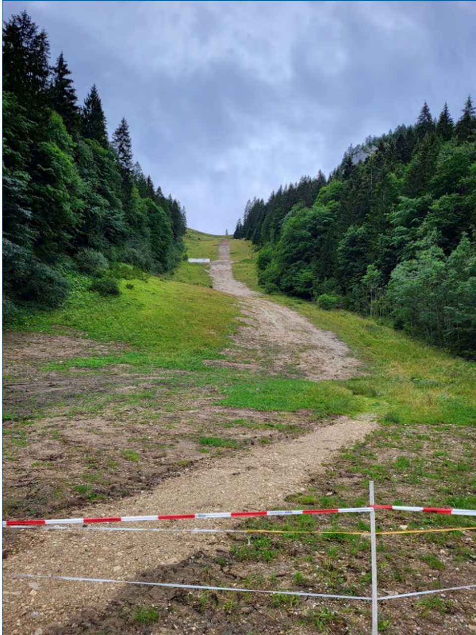
Abb. 2: Nur die noch nicht wieder gänzlich angewachsene Grasnarbe erinnert daran, dass die Rohre für Trinkwasser und Abwasser von der Raffner Alm hinauf zum Gipfelbereich in der Skipiste verlegt worden sind. Foto: Wasserwirtschaftsamt Traunstein
