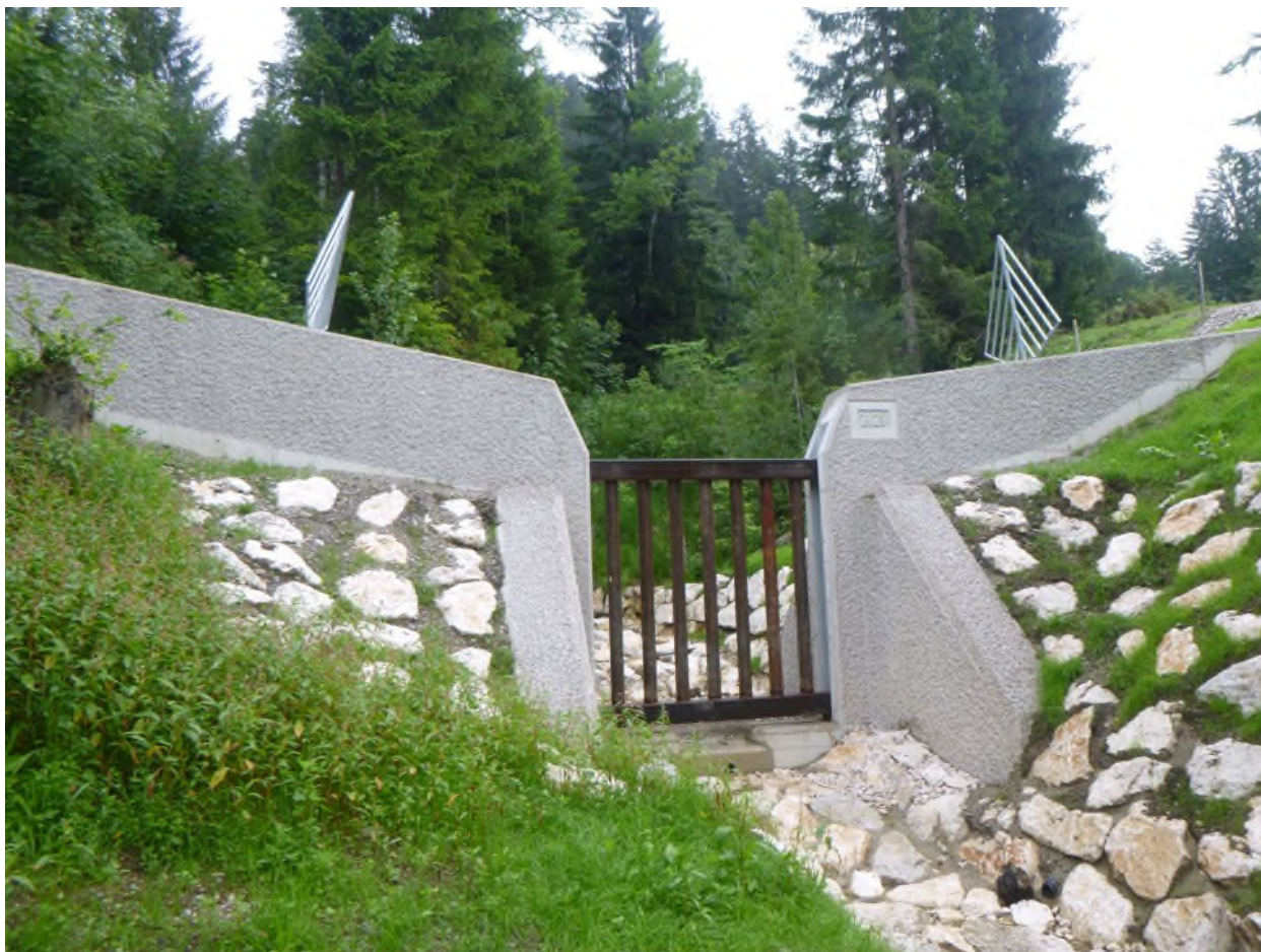
Abb. 3: Am Feichtgraben, einem Zufluss zum Hausbach in Reit im Winkl, ist eine Sperre entstanden. Sie sorgt dafür, dass das vom Hochwasser mitgeführte Totholz und Geröll zurückgehalten wird. Foto: Wasserwirtschaftsamt Traunstein
