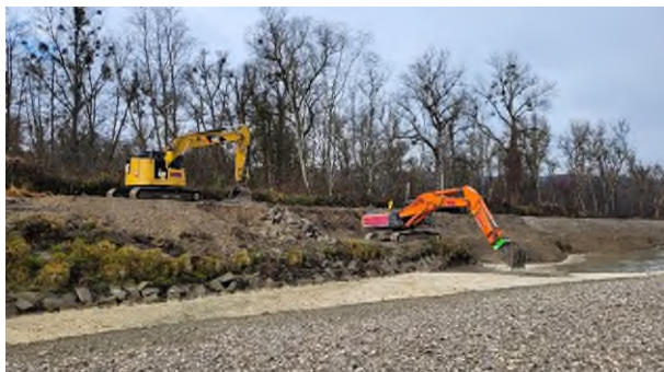
Abb. 1: Arbeiten zum Uferrückbau: Zwei Bagger graben im Bereich der Salzach bei Tittmoning rund 11.500 Tonnen Uferbausteine aus.
