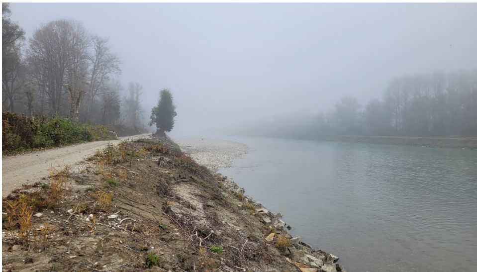
Der Uferbereich an der Salzach bei Tittmoning ist freigelegt. Jetzt können die Bagger mit dem Ausbau der Ufersteine beginnen. Foto: Wasserwirtschaftsamt Traunstein
