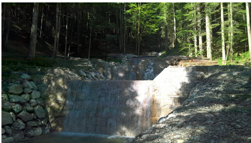
Abb. 1: Sanierte Sperren im Aufhamer Bach
