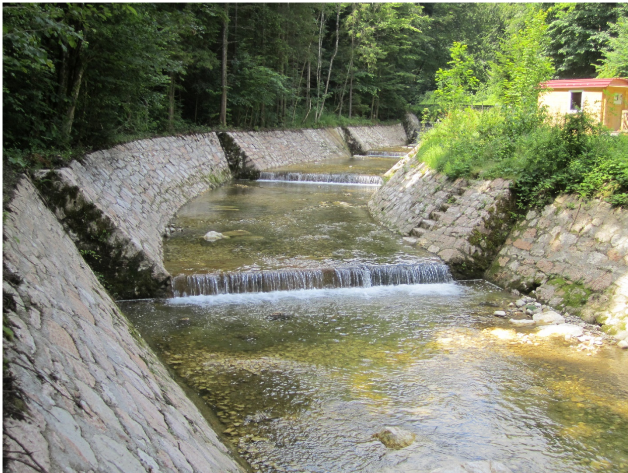
Abb. 1: Saniertes Gerinne der Oberteisendorfer Ache
