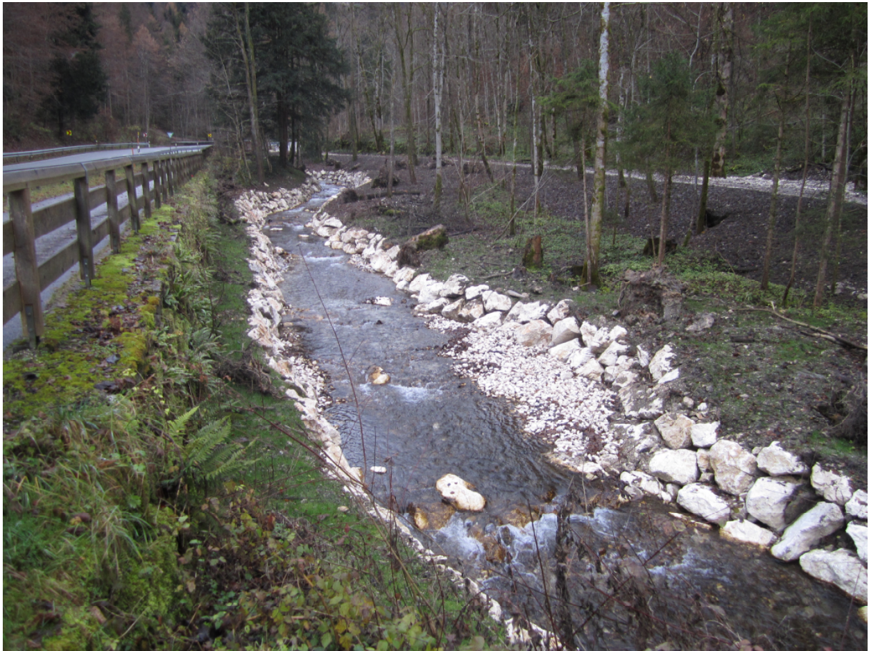
Bildunterschrift: Neue Ufersicherungen hat der Seebach in Bad Reichenhall erhalten, auf einem Teilabschnitt zwischen der Seebachkapelle und der Thumseestraße.
