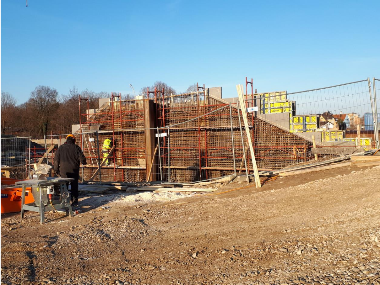
Absperrbauwerk am Freilassingener Mühlbach - Bewehrungsarbeiten an der rechten Außenwand - mit erkennbar der neue Deichquerschnitt
