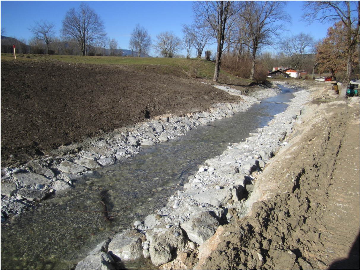
Schwarzbach, neuer Gewässerverlauf
