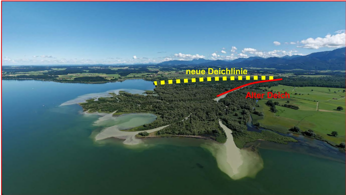
Das Mündungsdelta der Tiroler Achen mit altem Deich und der vorgesehenen neuen Deichlinie; Foto: Copyright Chiemsee-Alpenland Tourismus
