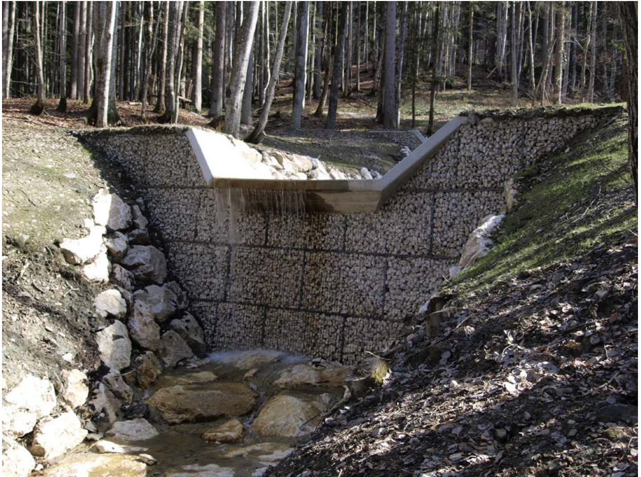
Drahtschottersperre im Teufelsgraben (Seitengraben des Tiefengrabens), vom Wasserwirtschaftsamt im Jahr 2015 errichtet
