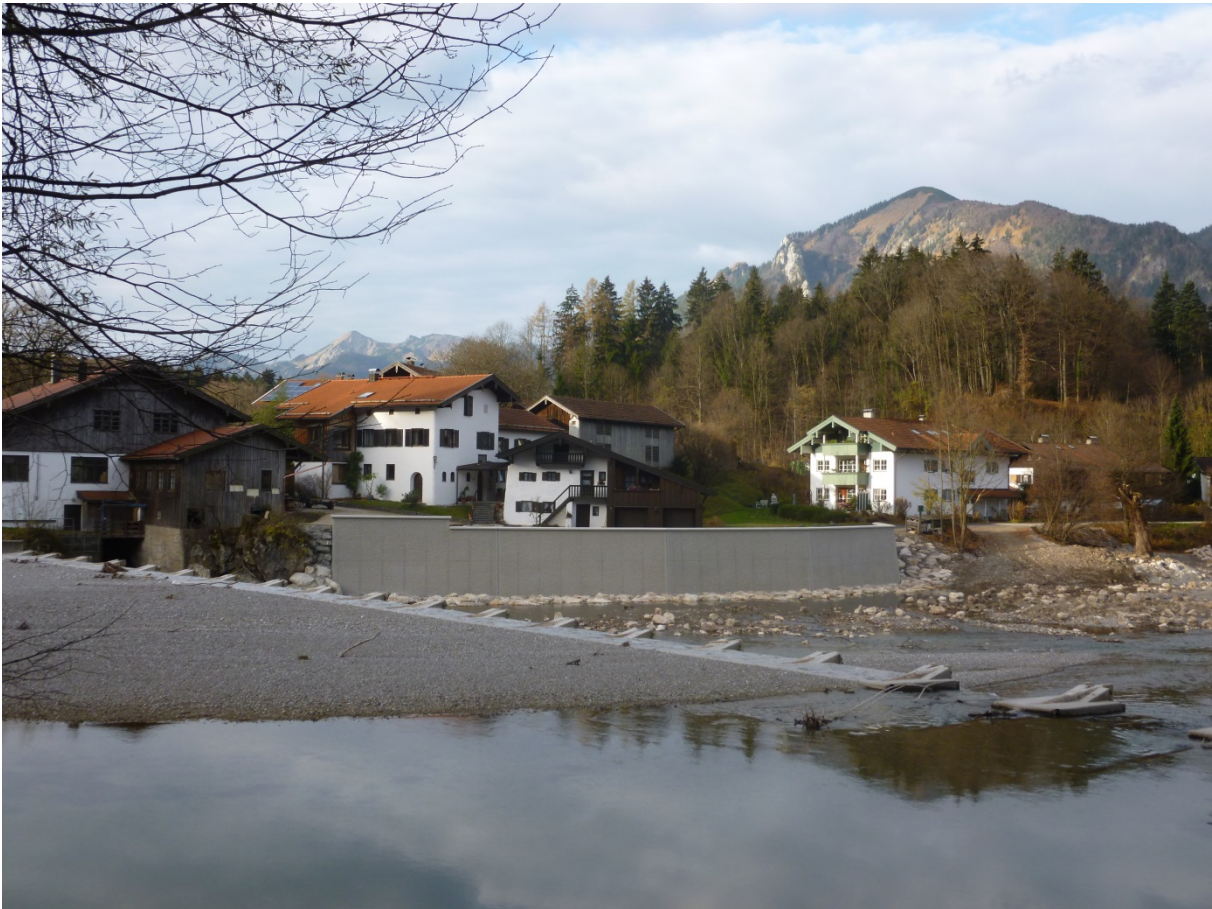
Ufermauer nach der Sanierung
