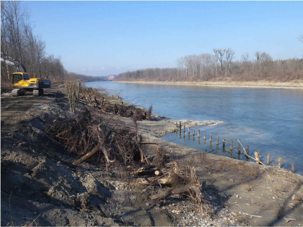
Foto: Mit den ingenieurb biologischen Sicherungen schafft das Wasserwirtschaftsamts Traunstein neue Lebensräume am Salzachufer. Rechts eine Pfahlreihe der historischen Verbauung, die bewusst belassen wurde.
